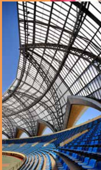
Für herausfordernde Architektur und zukunftsweisendes Design: Polycarbonat wird unter anderem zur Überdachung von Sportstadien genutzt wie hier in Peking, China.
